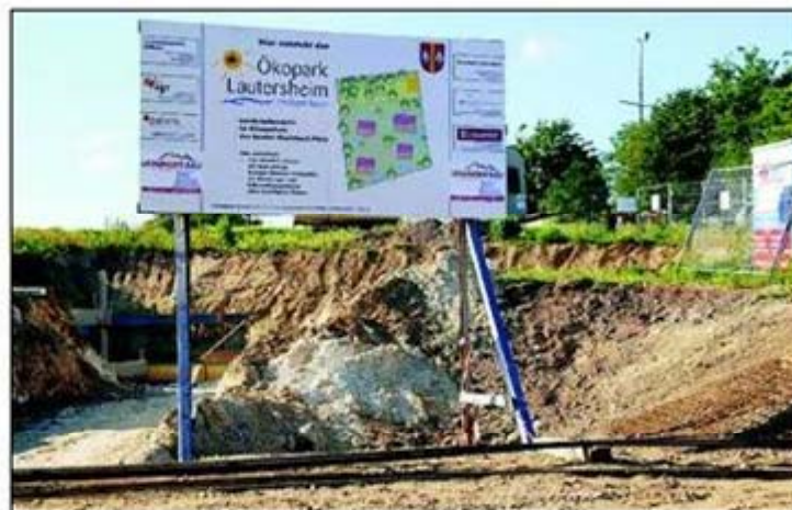
Auf dem Ökopark-Gelände sind die Arbeiten angelaufen. In acht Wochen sollen die Bohrungen für die Wärmepumpen beginnen.
